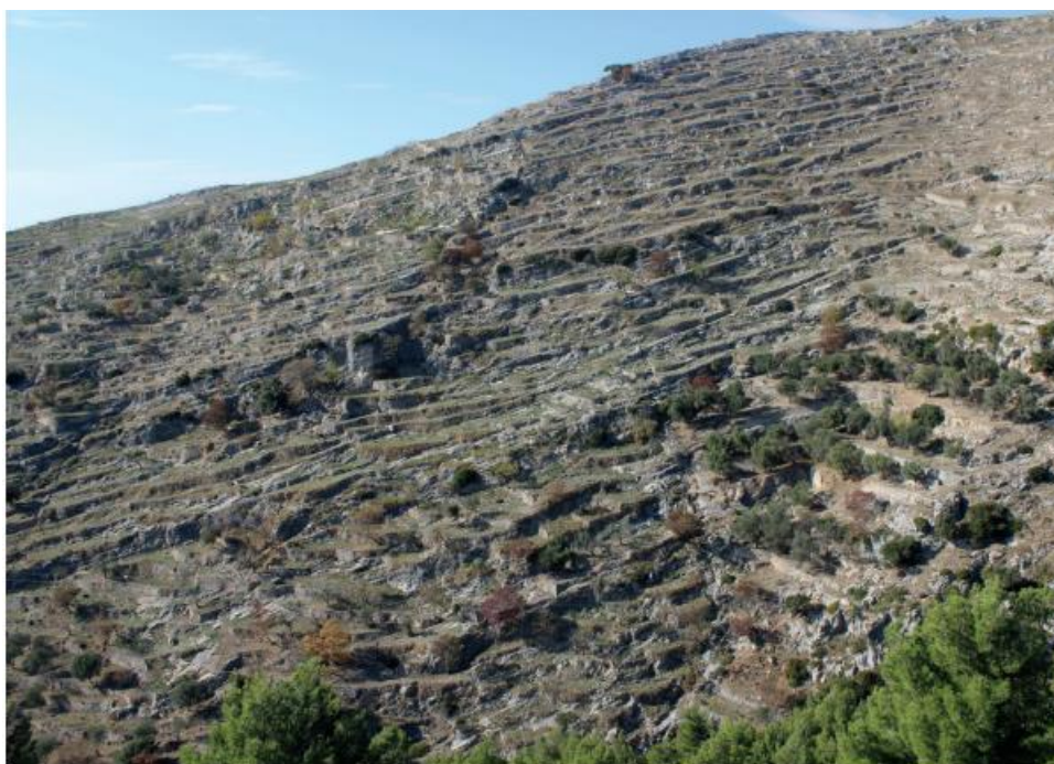
Foto 2 - Terrazzamenti di Monte S. Angelo. Foto Biscotti, 2020.
